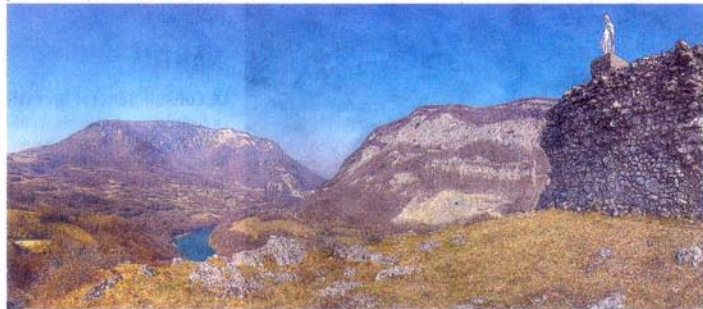
Vue sur Fort l'Ecluse depuis l'ancien château de Léaz, assemblage de 13 photos HDR, 36 megapixels
